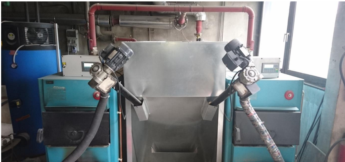
Slika 8: Postavitev peči v kurilnici.
