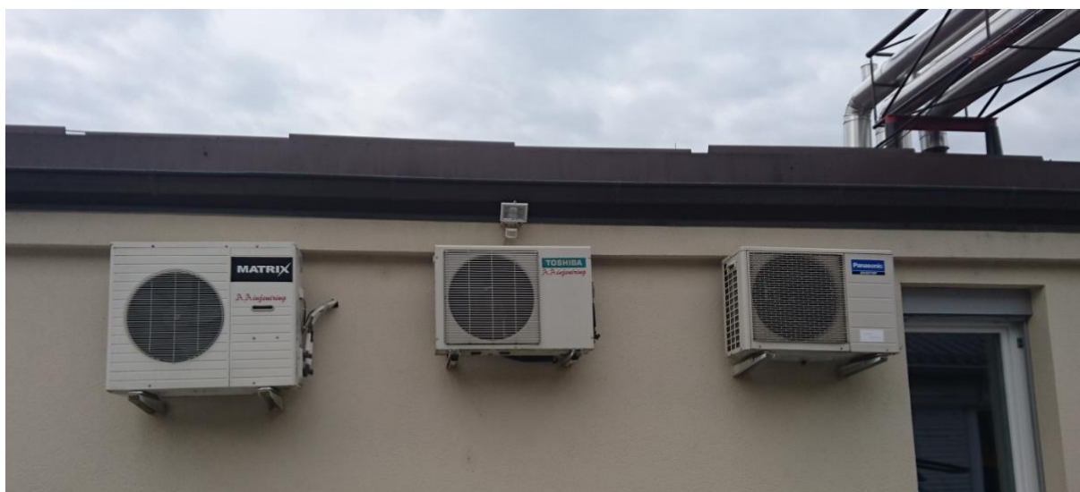
Slika 12: Klimatske naprave (zunanje enote).
