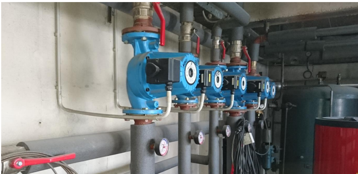
Slika 9: Razvod centralnega sistema ogrevanja.
