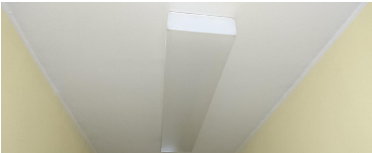
Slika 15: Svetilke s fluorescentnimi sijalkami
