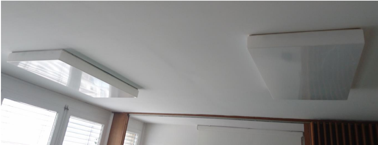
Slika 16: Svetilka s fluorescentnimi sijalkami, dušilko in mat pokrovom.
